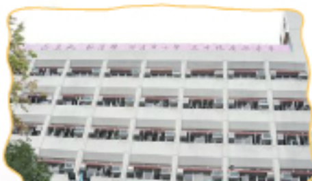
學校外牆翻新工程得以順利完成，感謝工程人員的辛勞付出。
