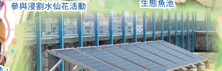
太陽能發電設施
